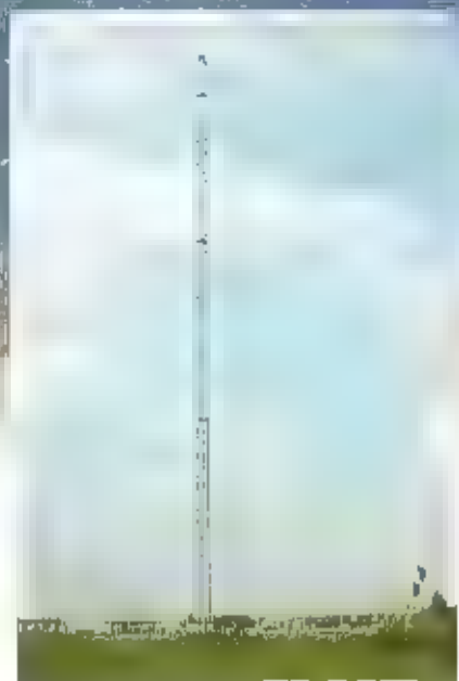
De noordelijke mast nog overeind
